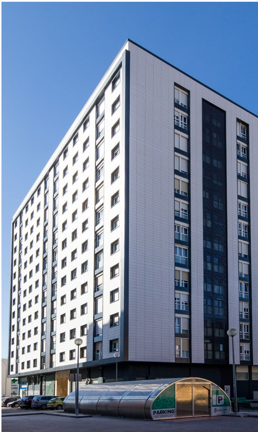
Proyecto de rehabilitación Torre Irrintzi, Pamplona.
