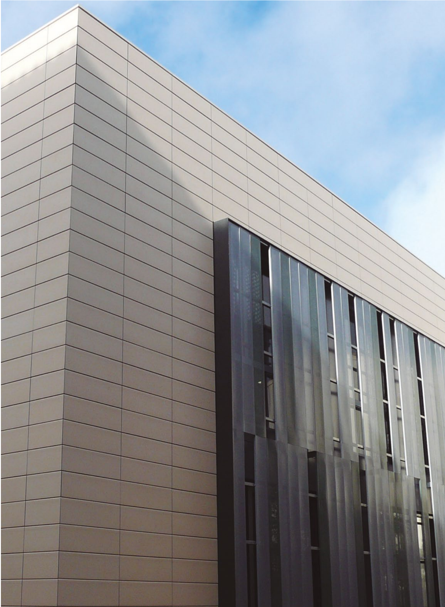
Edificio residencial Solsona, España.
