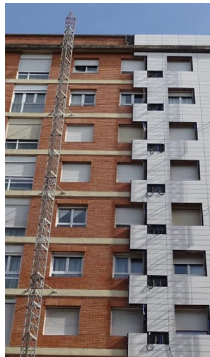
Foto de la rehabilitación.
